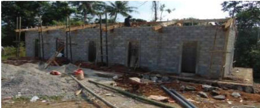
Proses pembangunan MC
