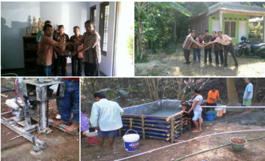
Penyerahan bantuan sumur pompa air bersih dan proses awal pembangunan
