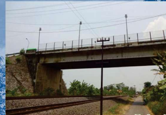
JALAN LAYANG FLY OVER
