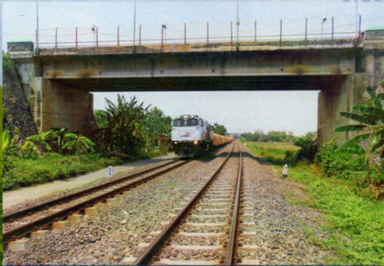
JALAN LAYANG FLY OVER
