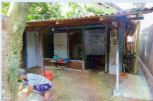
Rumah Sebelum di renovasi House before the renovation
